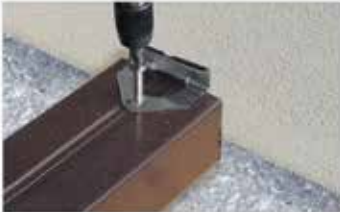
Anfangs-/Endclip montieren
