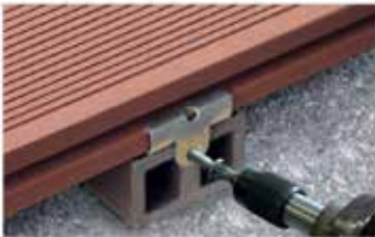
Anfangs-/Endclip montieren
