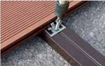
Mittelclip montieren
