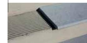
Poolrandplatten in Naturstein-Oberflächen immer vollflächig mit Zahnpachtel (Zahnung 10 mm) verlegen. Alle Stoßfugen sind mit Dehnfuge elastisch auszubilden, ebenso alle Anschlussfugen.
