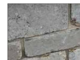
Mauern Sie die Steine und Abdeckplatten mit Steinmörtel Plus unter Einhaltung einer Fugenbreite von 1 cm aufeinander. Die Steinöffnungen werden ebenfalls mit dem Steinmörtel gefüllt. 1 Sack Steinmörtel reicht für ca. 12 Steine. Die Fugen sind unbedingt zu verdichten, z.B. mit einem Fugeisen, ansonsten erhöhte Neigung zu Ausblühungen.
