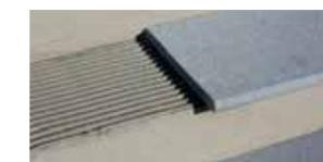
Stufenplatten in Naturstein-Oberflächen immer vollflächig mit Zahnpachtel (Zahnung 10 mm) verlegen. Alle Stoßfugen sind mit Dehnfuge elastisch auszubilden, ebenso alle Anschlussfugen.
