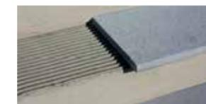
Poolrandplatten in Naturstein-Oberflächen immer vollständig mit Zahnpachtel (Zahnung 10 mm) verlegen. Alle Stoßfugen sind mit Dehnfuge elastisch auszubilden, ebenso alle Anschlussfugen.
