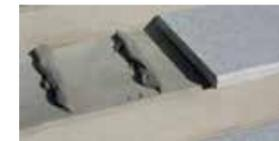
**i** Abdeckplatten in LeichtRein-Oberflächen immer auf Mörtelbändern verlegen um temperaturbedingte Spannungen auszugleichen (Auftreten von Spannungsrissen). Alle Stoßfugen sind mit Dehnfuge elastisch auszubilden, ebenso alle Anschlussfugen.
