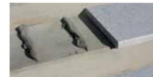
**i** Evo-Abdeckplatten immer auf Kleberbändern verlegen um temperaturbedingte Spannungen auszugleichen (Aufreten von Spannungsrissen). Alle Stoßfugen sind mit Dehnfuge elastisch auszubilden, ebenso alle Anschlussfugen.
