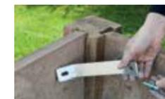
Bretter in die Ausnehmungen der Ecksäulen schieben und mit Montagematerial fixieren. Die Schraubmutter sind im Brett werkseitig eingebaut, Winkel mit Schrauben anschrauben.
