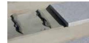
**i** Stufenplatten in LeichtRein-Oberflächen immer auf Mörtelbändern verlegen um temperaturbedingte Spannungen auszugleichen (Auftreten von Spannungsrissen). Alle Stoßfugen sind mit Dehnfuge elastisch auszubilden, ebenso alle Anschlussfugen.
