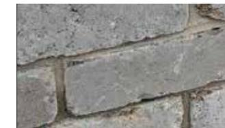
Mauern Sie die Steinziegel mit "Steinmörtel Plus" unter Einhaltung einer Fugenbreite von ca. 1 cm aufeinander. Die Fugen sind unbedingt zu verdichten, z.B. mit einem Fugeisen, ansonsten erhöhte Neigung zu Ausblühungen.
