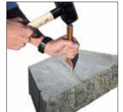
Mit einem Breitmeißel können Sie die Steine einfach auf das von Ihnen gewünschte Maß selbst brechen - zum Beispiel für Anfang- oder für Endsteine, oder für Steine auf Maß. Eine, mit dem Winkelschleifer vorge-schnittene „Sollbruchstelle“ erleichtert diesen Brechvorgang
