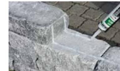
Kleben Sie die Steine mit Häusler Dichtkleber im Zuge des Aufbaues zusammen.
