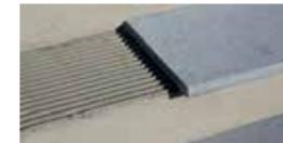
Abdeckplatten in Naturstein-Oberflächen immer vollflächig mit Zahnpachtel (Zahnung 10 mm) verlegen. Alle Stoßfugen sind mit Dehnfuge elastisch auszubilden, ebenso alle Anschlussfugen.
