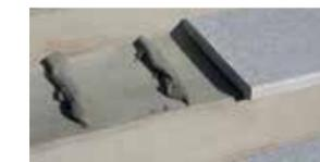
**Poolrandplatten in LeichtRein-Oberflächen immer auf Mörtelbändern verlegen um temperaturbedingte Spannungen auszugleichen (Auftreten von Spannungsrissen). Alle Stoßfugen sind mit Dehnfuge elastisch auszubilden, ebenso alle Anschlussfugen. Beachten Sie bitte, dass es bei einer Kombination von Profi-Produkten und Exklusiv-Produkten zu Farb- und Strukturunterschieden kommen kann.**
