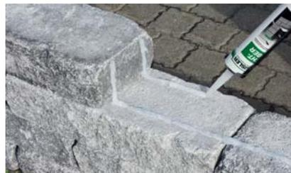
Kleben Sie die Steine mit Häusler Dichtkleber im Zuge des Aufbaues zusammen.
