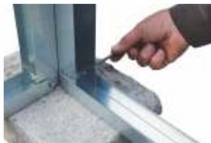
2. Untere Metallprofile einsetzen und handfest anschrauben.
