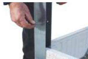
5. Linsenkopfschrauben M6x50 mittig in die Ecksteher handfest anschrauben und die restlichen Wandplatten einsschieben.
