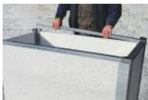
6. Obere Metallprofile aufsetzen und einrichten.
