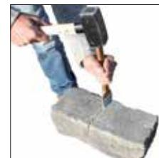
Mit einem Breitmeißel können Sie die Steine einfach auf das von Ihnen gewünschte Maß selbst brechen - zum Beispiel für Anfang- oder für Endsteine, oder für Steine auf Maß. Eine mit dem Winkelschleifer vorgeschaltete „Sollbruchstelle“ erleichtert diesen Brechvorgang
