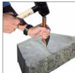
Mit einem Breitmeißel können Sie die Steine einfach auf das von Ihnen gewünschte Maß selbst brechen - zum Beispiel für Anfang- oder für Endsteine, oder für Steine auf Maß. Eine, mit dem Winkelschleifer vorgeschnittene „Sollbruchstelle“ erleichtert diesen Brechvorgang
