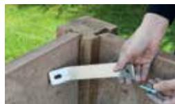
Bretter in die Ausnehmungen der Ecksäulen schieben und mit Montagematerial fixieren. Die Schraubmuttern sind im Brett werkseitig eingebaut, Winkel mit Schrauben anschrauben.
