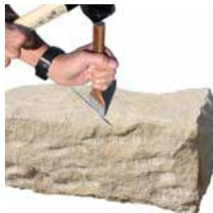
Mit einem Breitmeißel können Sie die Steine einfach auf das von Ihnen gewünschte Maß selbst brechen - zum Beispiel für Anfangs- oder für Endsteine, oder für Steine auf Maß. Eine mit dem Winkelschleifer vorgeschnittene „Sollbruchstelle“ erleichtert diesen Brechvorgang
