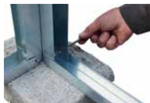
2. Untere Metallprofile einsetzen und handfest anschrauben.
