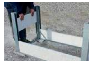
4. unterste Wandplatten von oben in die Eckpfiler einschieben.
