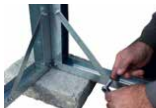
3. Querstreben montieren.
