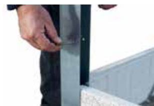
5. Linsenkopfschrauben M6x50 mittig in die Ecksteher handfest anschrauben und die restlichen Wandplatten einsschieben.
