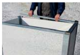
6. Obere Metallprofile aufsetzen und einrichten.
