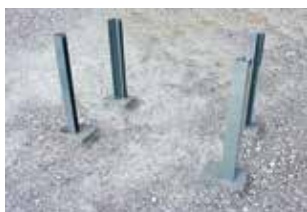
1. Ecksteher zusammenbauen und auf, in die waagerechte eingerichteten, Auflagersteine im Rastermaß von ca. 120 x 60 cm aufstellen.
