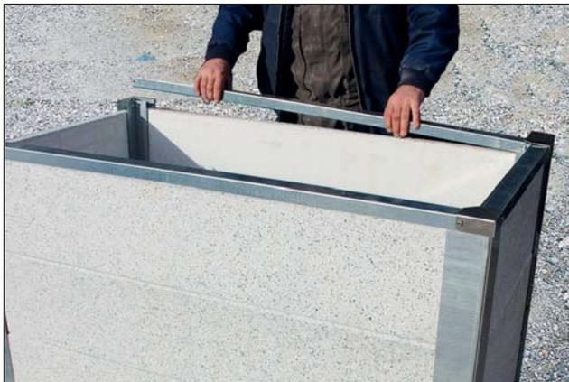
6. Obere Metallprofile aufsetzen und einrichten.
