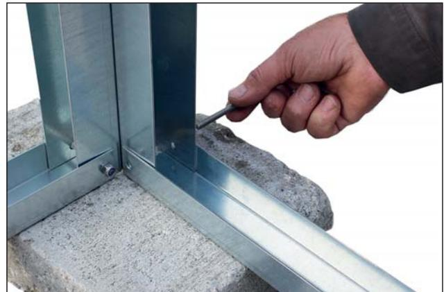
2. Untere Metallprofile einsetzen und handfest anschrauben.
