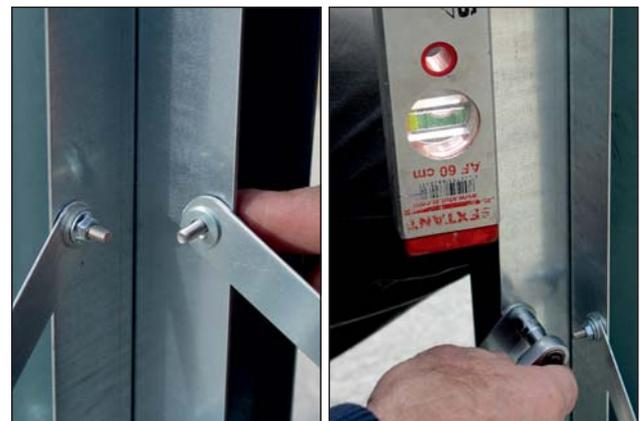
3a. **Achtung:** Querstreben lt. Bild montieren und mit der Wasserwaage alles senkrecht (im rechten Winkel) einrichten. Schrauben in diesem Bereich festziehen!
