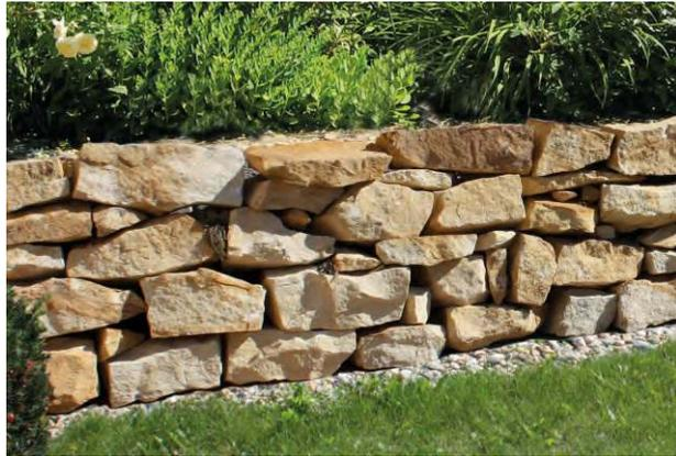
Mögliche Aufbauhöhe - Richtwerte als Stützmauer max. 60 cm
