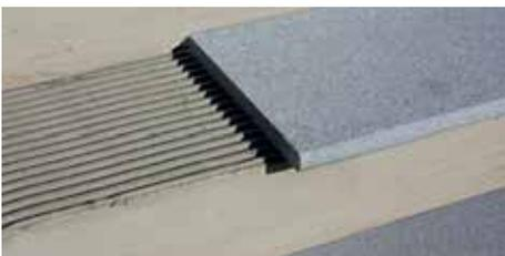
**i** Abdeckplatten in Naturstein-Oberflächen immer vollflächig mit Zahnpachtel (Zahnung 10 mm) verlegen. Alle Stoßfugen sind mit Dehnfuge elastisch auszubilden, ebenso alle Anschlussfugen.
