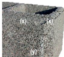
Baumeistersteine weisen produktionsbedingt, mehr oder weniger ausgeprägte „Grate“ = Betonreste siehe (x) auf den Kanten und Fasen auf.
