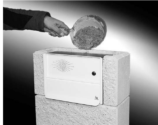
4. Alles ausbetonieren - durch stochern verdichten
