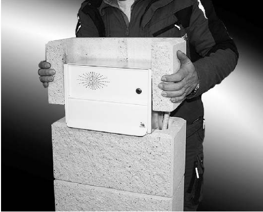
3. Obersten zugeschnitten Stein mit Dichtkleber aufsetzen und Briefkasten einrichten und richtig positionieren. Eventuell mit Kunststoff-Keilen fixieren.
