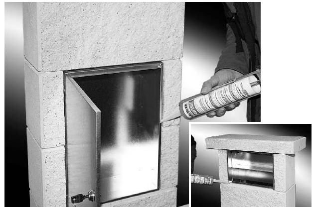
6. Frontplatte und Entnahmetür ausbauen. Mit Häusler-Dehnfuge abdichten. Frontplatte und Entnahmetür wieder einbauen.
