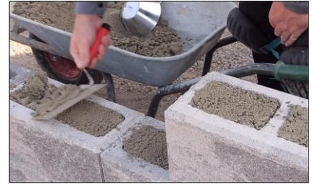
Den Füllbeton sorgfältig einbringen, durch stochern verdichten und exakt mit der Oberkante der Zaunsteine abziehen.
