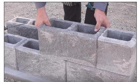
Häusler Dichtkleber auf die erste Steinreihe auftragen und den ersten Stein der zweiten Steinreihe darauf versetzen. Die Stoßfugen zwischen den Steinen der zweiten Steinreihe ebenfalls wieder mit Dichtkleber schließen. Bei einer eventuellen weiteren Steinreihe wird wieder mit einem ganzen Stein begonnen, und so weiter.
