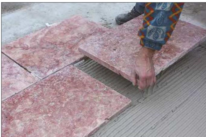
**Hinweis:** Ein Auftragen des Steinklebers sowohl auf dem Untergrund als auch auf der Platten-Unterseite nennt man Buttering/floating-Verfahren.
