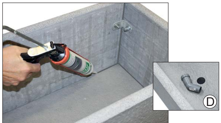
6. Abdichten aller Fugen mit Dichtkleber. Der Bodenablauf (D) ist für Abflussrohre in der Stärke von Dm. 40 mm vorbereitet. Abflussrohr (nicht im Lieferumfang enthalten) mit Dichtkleber einkleben.
