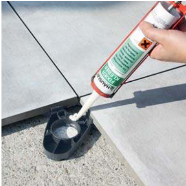
Format 45 x 45 cm 18 mm dünn 4 Plattenlager Papillon
