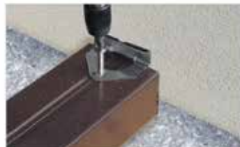
Anfangs-/Endclip montieren
