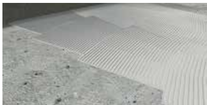
Spezial-Klebemörtel vollflächig mit Zahnpachtel 10/10 auf dem Untergrund auftragen
