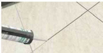
Alle Fugen dauerelastisch mit Dehnfuge verschließen
