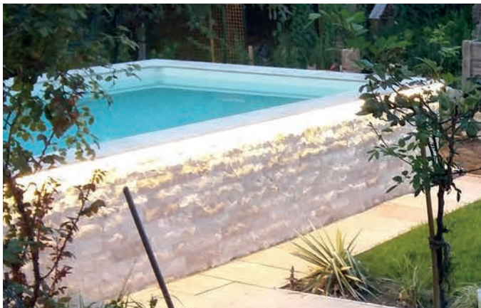
LED- Beleuchtung fertig in Poolrandplatten eingebaut.
