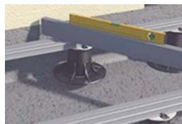
Mit Wasserwaage die waag-rechte prüfen und die Stelzlager dementsprechend verstellen.
